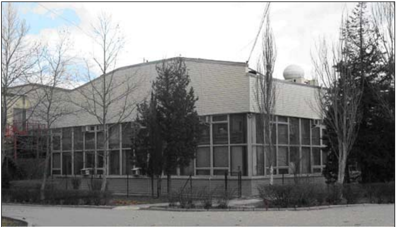
Фото 1. Общий вид лабораторного корпуса 2 Испытательного центра «Омега»
